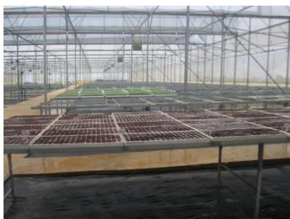
Kết cấu khung vườn ươm
